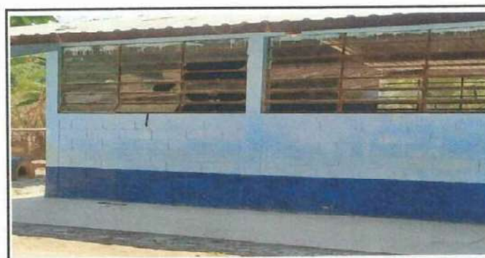
Foto 6: Se observa el area de ventanería piezas de vidrios en mal estado del modulo 3.
